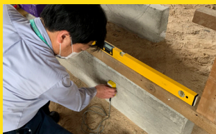
耐震インスペクション
